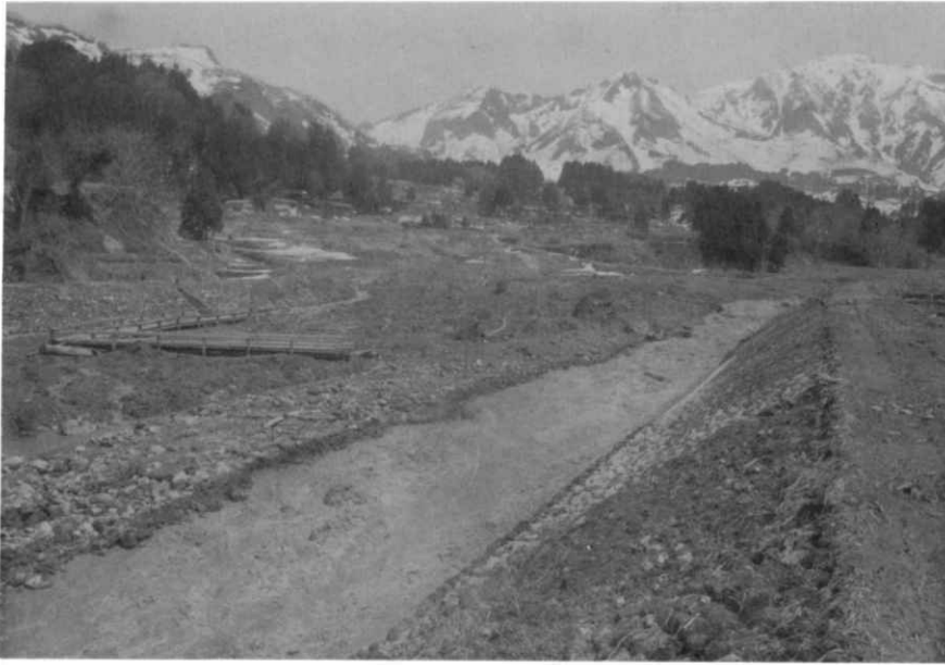
写真9.3 前川に流出した土砂と壊れた橋
