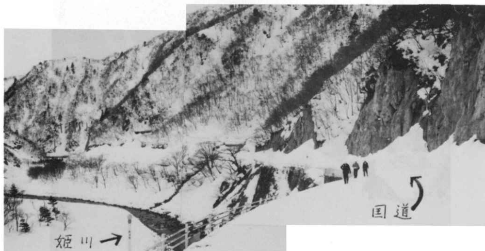
写真6.5 姫川沿いの国道148号(小滝—平岩間)
