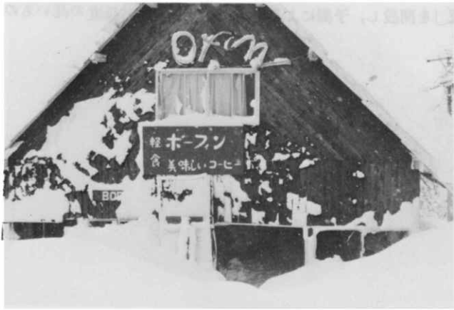
(2) 軽食堂前面に吹付けられた雪煙，頭文字Bが落ちている
