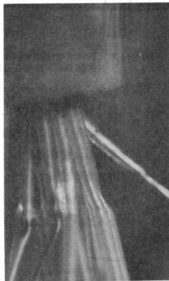
写真6 W-2型水密モールド・フロー止め金具付近における心線の変形(テーパームールド下部とエポキシ樹脂を取り除いて、コアを見やすくした。昭和50年12月撮影)。
