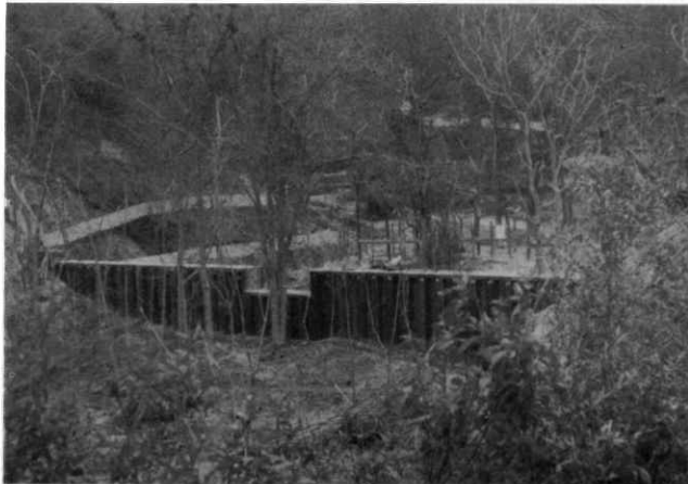
B - 1 下流部ですすめられてい る砂防ダム工事。山腹に はフェンスが設置されて いる。
