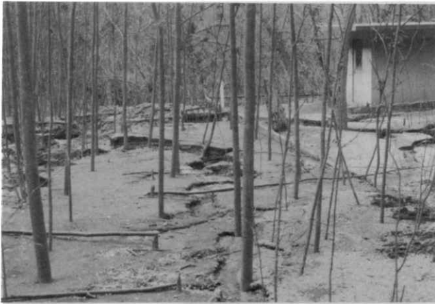
B - 2 下流のポンプ小屋付近の 河床状況。埋まったフェ ンスから考えて、1 m以 上の降下堆積物が存在す ると推定される。
