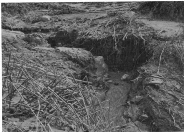
4 - 3 道と沢の交叉部で下流側からガリーが形成されている。
