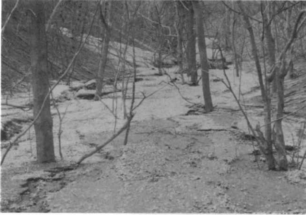
B - 3 中流部の河床状況。 堆積物上に数回の泥流の 流下痕が認められる。山 腹からの土砂供給も盛ん である。
