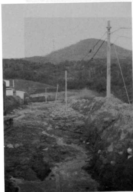
4 - 1 道路を河道として流出した，4の沢の泥流痕。道路からはずれた部分では，深いガリーを刻んでいる。
