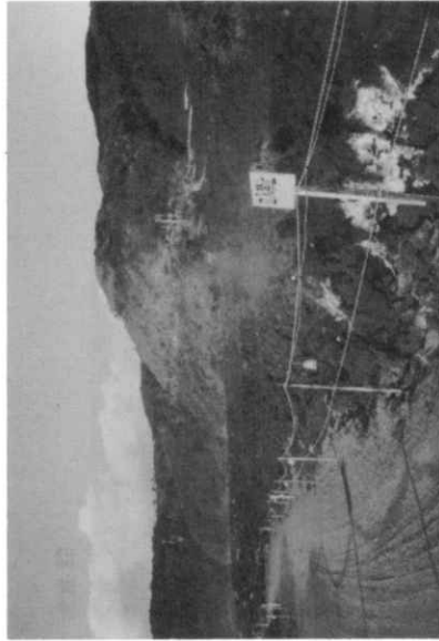
写真29 熔岩流の上に土をのせて道路とした。この道路の位置は熔岩で埋れる前の道路とほぼ同位置とのことである。この道路上には停車しないことという立札が立っている。それは、まだ熔岩が冷え切っていないため停車しているとタイヤ等が熱くなるとを配慮したものと思われる。阿古地区。
