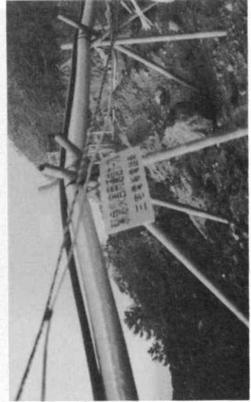
写真34 35 地表に設置された給水管。地中に埋設するよりは速く復旧できる。車輦等で破壊されなければ良いが、今回の火山活動によって三宅島では地殻変動がみられないから良いが、1977年有珠山噴火のような地殻変動が発生すると接手部分をフレキシブルにしなければならぬ。
