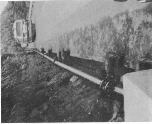
写真34 35 地表に設置された給水管。地中に埋設するよりは速く復旧できる。車輦等で破壊されなければ良いが、今回の火山活動によって三宅島では地殻変動がみられないから良いが、1977年有珠山噴火のような地殻変動が発生すると接手部分をフレキシブルにしなければならぬ。
