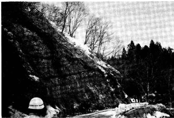
写真9 町道脇のカットされた法面。上方には雪崩棚がみえる。シャベルカーは作業員によって落された残雪を処理中のもの、ブッシュや低立木の根曲りの様子が良く見える。
