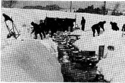
写真1 流雪溝実験
