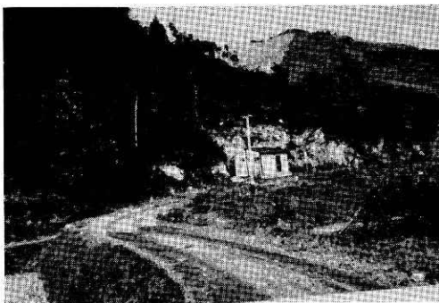
写真 1 えびの・吉松地区地震測定室と観測井戸
