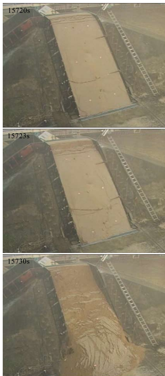
図 18 大型 40 度マサ斜面崩壊時の状況 Fig. 18 Behavior of slope failure of sand slope of 40 degree.
