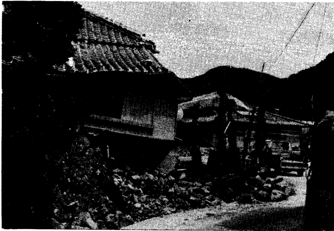
写真33～35 くずれ落ちた石垣(10 入間)
