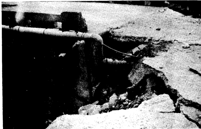
写真一 2 2 左側は急斜面崩壊防止の工事が施工してあったため被害はなかった。右側は何もなかったため、急斜面の岩石が崩壊し、大木をなぎ倒し真下の家屋数戸に被害を与えた。 ( 1 0 日 南伊豆町役場前 )
