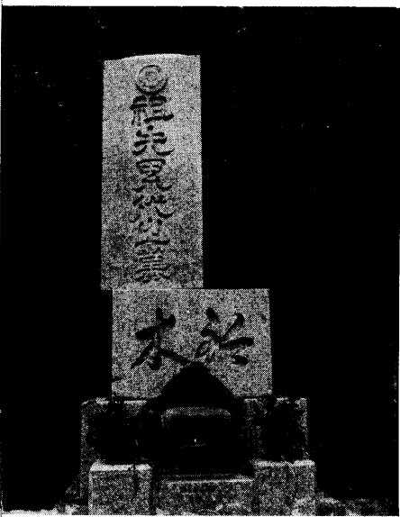
写真一20 墓石のずれ。(N45°E8cm)(11日 石廊崎)
