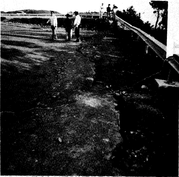
写真一18. 伊浜部落背後の マーガレットライン駐車場末 端に入った亀裂。
