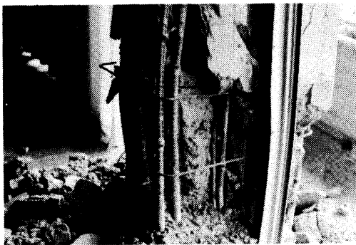
写真 2 2 Aブロック1階食堂柱の破壊
