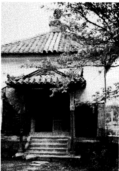
写真 6 老朽家屋の被害（庄内町下武宮）
