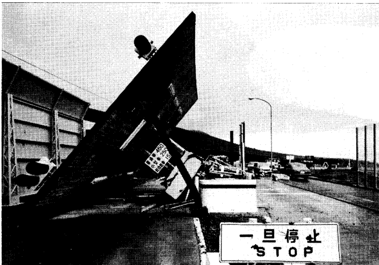
写真 1 3 九州横断道路小田野池料金所の倒壊
