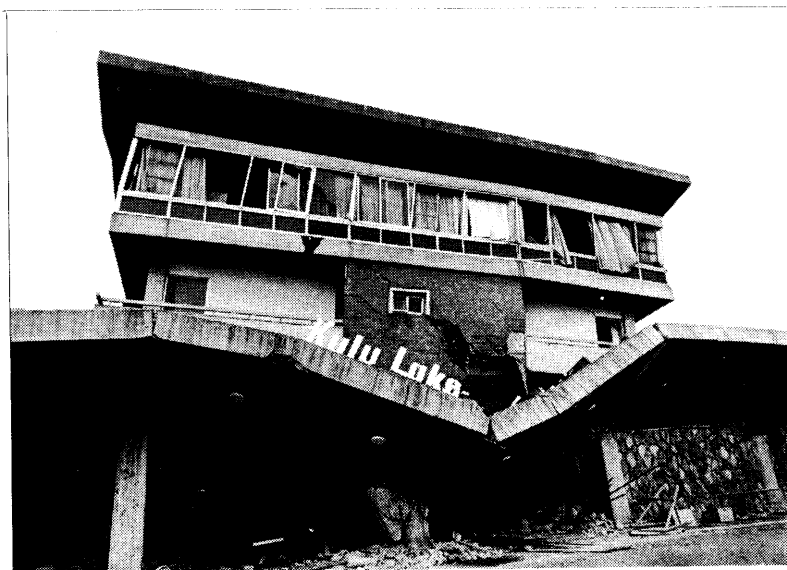
写真 1 4 九重レークサイドホテルの被害状況
