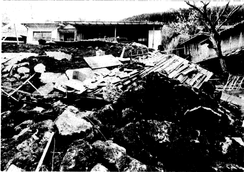
写真 1 2 庄内町内山の盛土石積および家屋の被害
