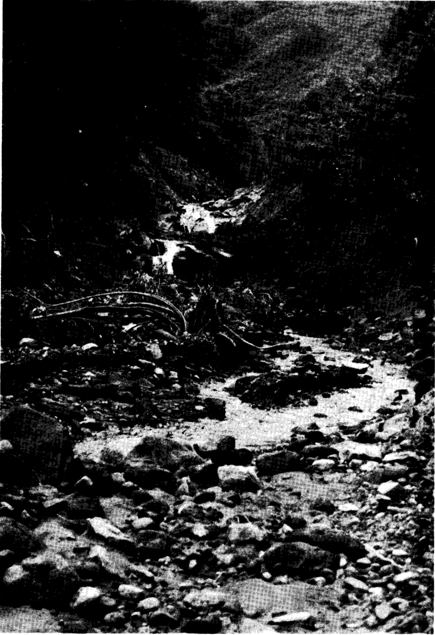
写真-5 蔵助沢第1号床固工より下流の溪岸侵食の状況
