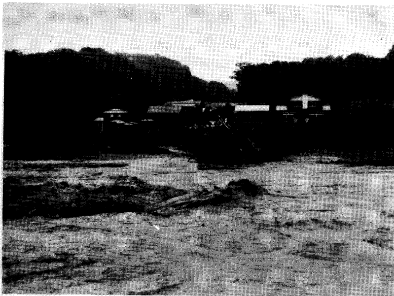
写真一 1 真室川地区、(a)地区、50年8月6日 真室川町新橋流失
