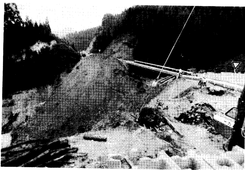
写真一八 及位地区 50年8月14日 国道13号線主寝坂トンネル 秋田県側、車の見えるところが 道路だつた。
