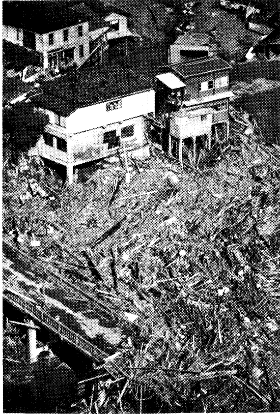
写真- 8 勝賀瀬川川口国道194号線の旧橋（高知県提供）
