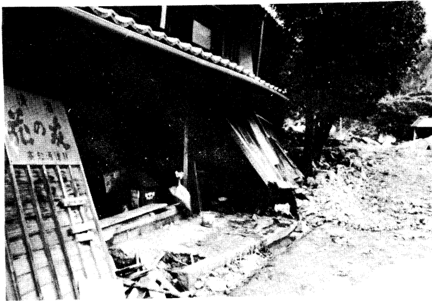
写真-10 崩壊時の水圧によって破壊された家屋 (吾北村寺野部落)
