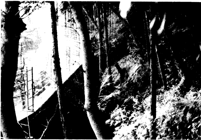
写真 6.3 成東町真行寺の崩壊
