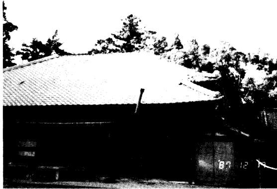
写真 2.1 旧住居で屋根瓦の被害例（長生村）
