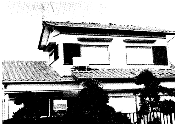
写真 2.2 新住居で屋根瓦の被害例（長生村）
