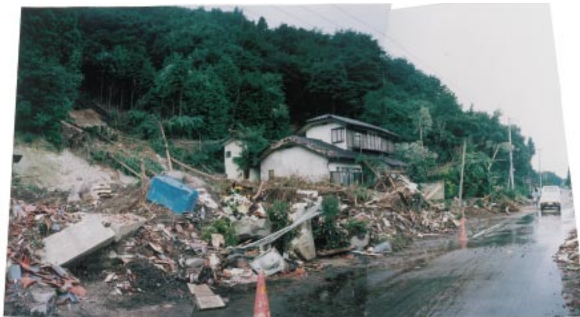
写真9 葎ノ目の崩壊による被害状況 Photo 9 Damaged area of the Yoshinome landslide.
