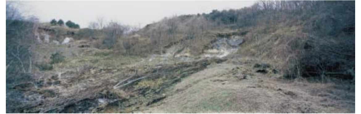
写真15 畜産団地内に生じた流動性崩壊 Photo 15 Flow type landslide.
