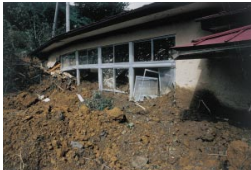
写真14 柏野の製材所裏の崩壊により埋まった家屋 Photo 14 Damaged houses at Kashiwano.
