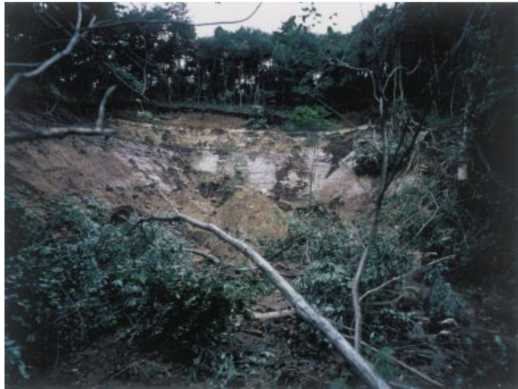
写真7 からまつ荘裏の右岸側の崩壊 Photo 7 Right side source of the Karamatsu-sou landslide.
