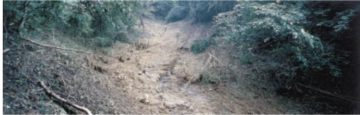
写真8 からまつ荘裏崩壊からの土砂の流送路の状況 Photo 8 Flow route of the Karamatsu-sou landslide.
