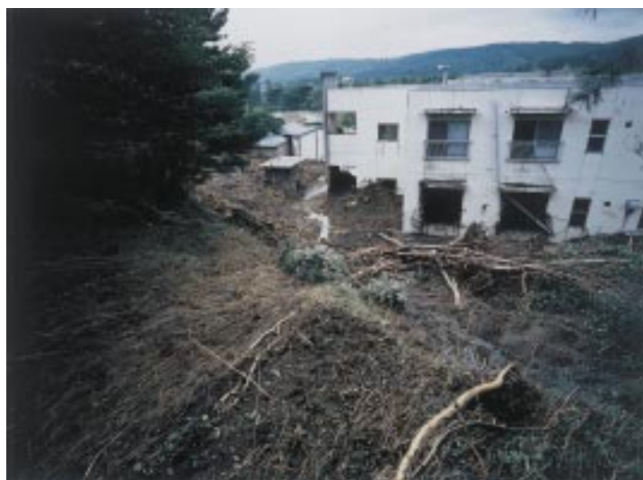
写真2 土砂の直撃を受けたからまつ荘の被災状況 Photo 2 Karamatsu-sou directly hit by landslide debris.
