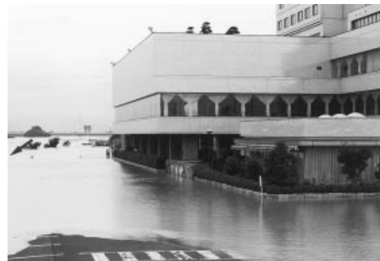
写真20 水戸市水府町川岸に建つホテルの浸水状況 [茨城県提供]
