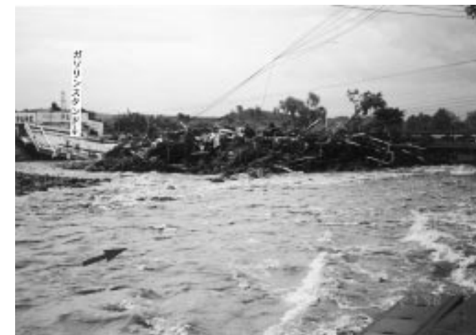
写真4.2 余笹橋の流木等による閉塞状況と流失したガソリンスタンド [栃木県提供] Photo 4.2 Yosasagawa bridge blocked by floating logs and a washed away gas station.
