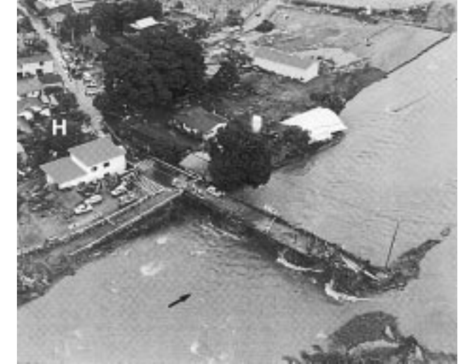
写真8.5 寺子地区石田坂の被害と寺子橋損壊状況 [ 栃木県提供 ] Photo 8.5 Terako area damaged by the 1998-flood.
