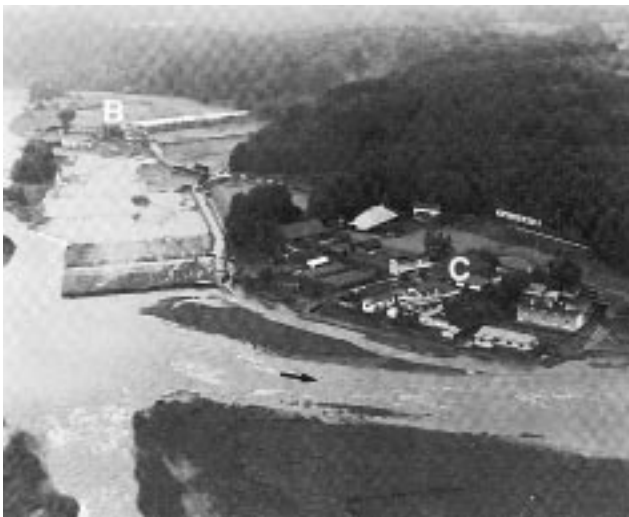
写真8.3 段丘下位面に建つ赤沼地区の集落 [ 栃木県提供 ] Photo 8.3 Terako area damaged by the 1998-flood.
