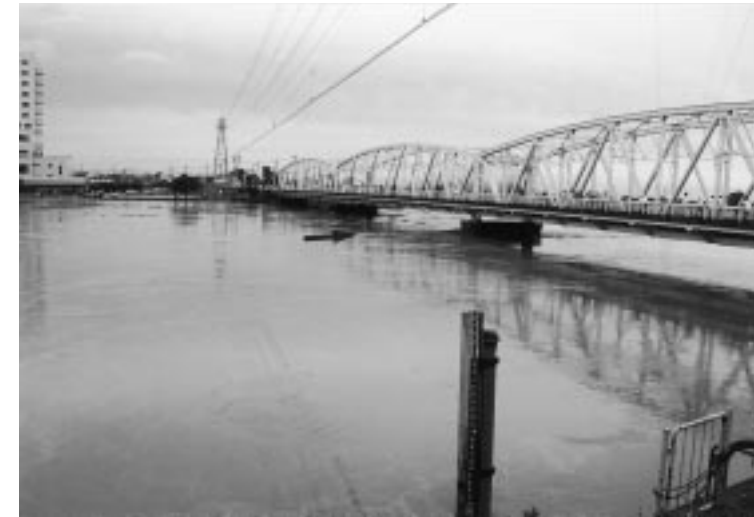
写真18 水戸市水府橋付近の増水状況 [茨城県提供]
