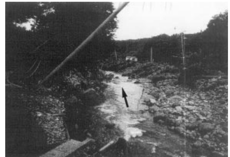
写真1 別荘地を横切る洪水流路 [ 栃木県提供 ]
