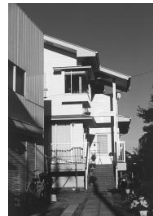
写真17 水害への住民の防備：住宅基礎の嵩上げ Photo 17 Raising housing lot level in preparation for floods.
