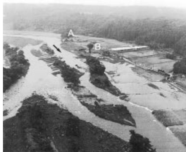
写真8.2 寺子地区赤沼被災状況：洪水流路の形成 [ 栃木県提供 ] Photo 8.2 Terako area damaged by the 1998-flood.
