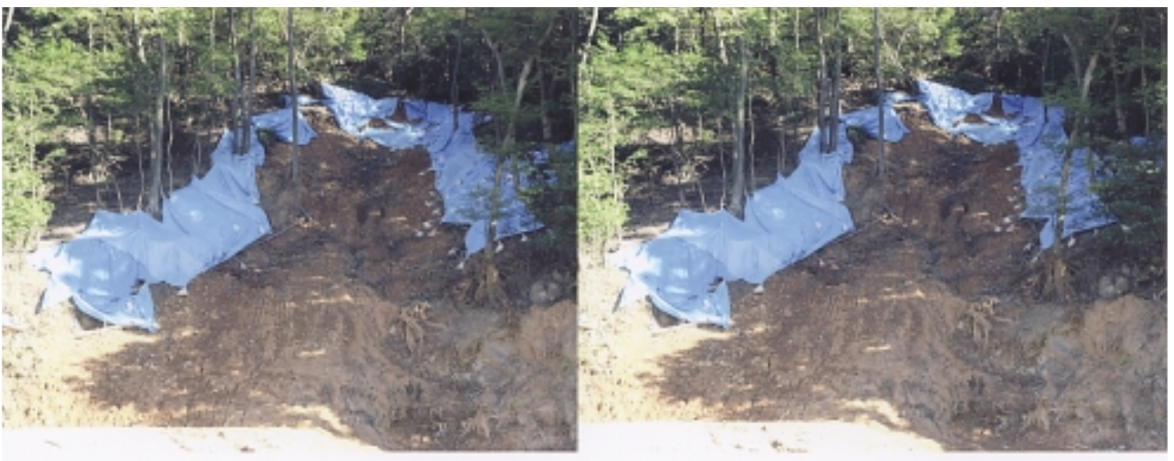
写真5 小牧市大山崩壊地全景（実体視用ペア写真）
