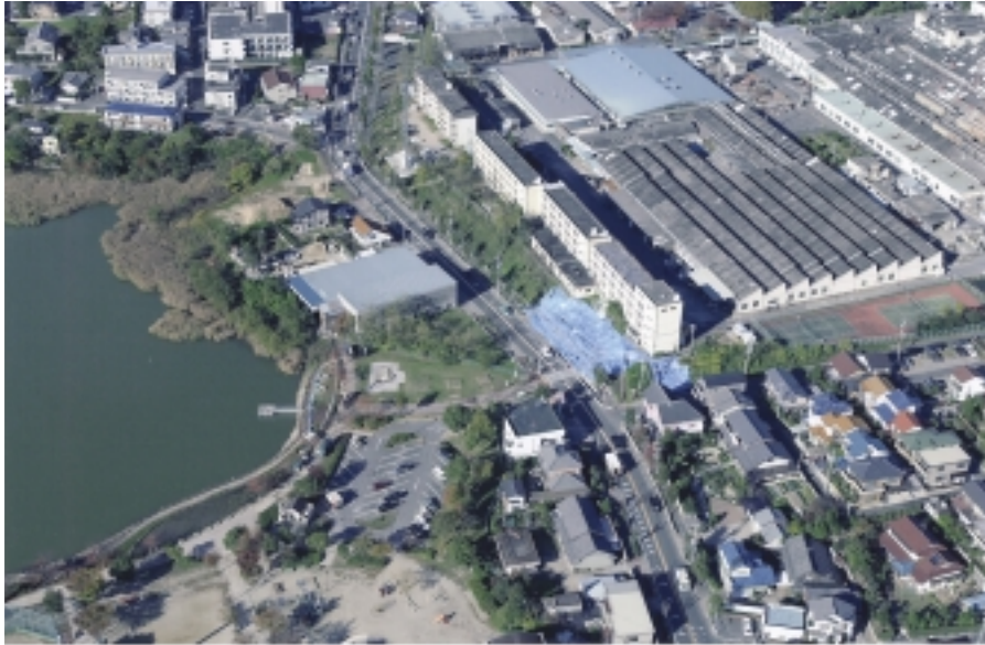
写真1 空撮による名古屋市緑区鳴海町伝治山の崩壊地周辺の状況。 写真中央のブルーシートで覆われた部分が崩壊場所，写真中央を市道が東西に貫いている，写真右上は製陶工場，左は新海池
