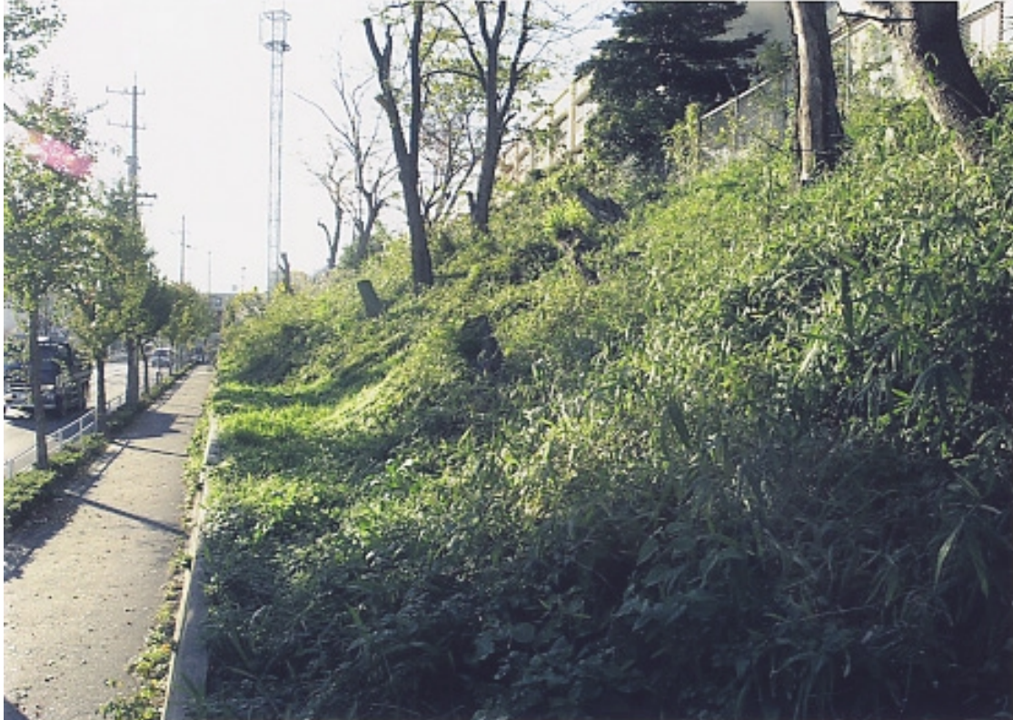
写真2a 未崩壊斜面と歩道の状況（緑区鳴海町）
