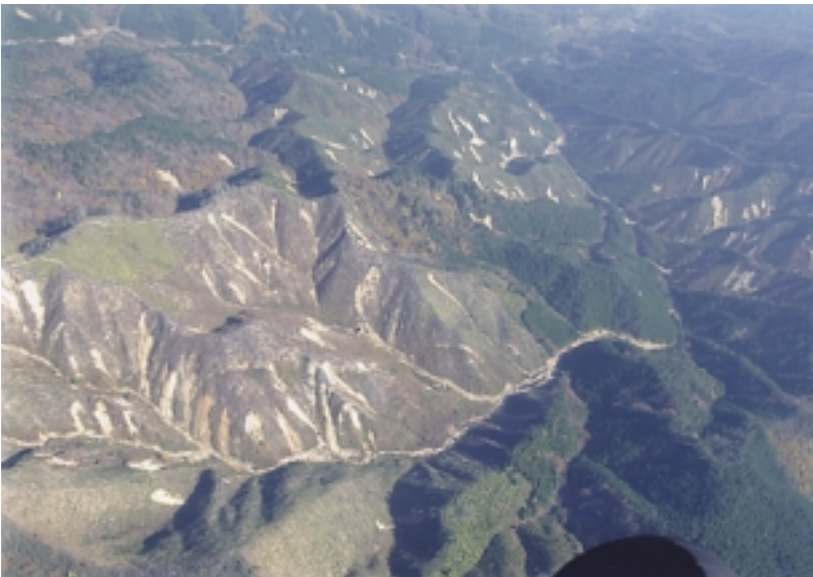
写真9b 空撮による山林での斜面崩壊発生状況
