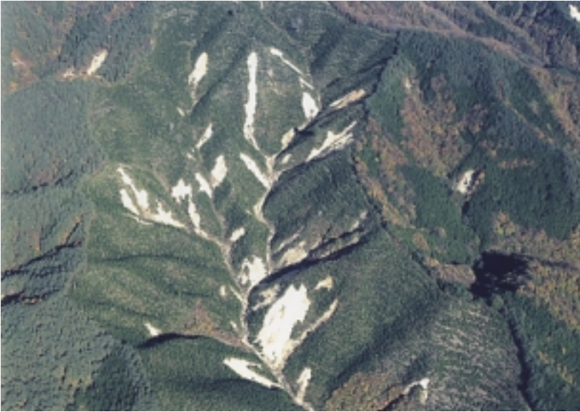
写真9a 空撮による山林での斜面崩壊発生状況
