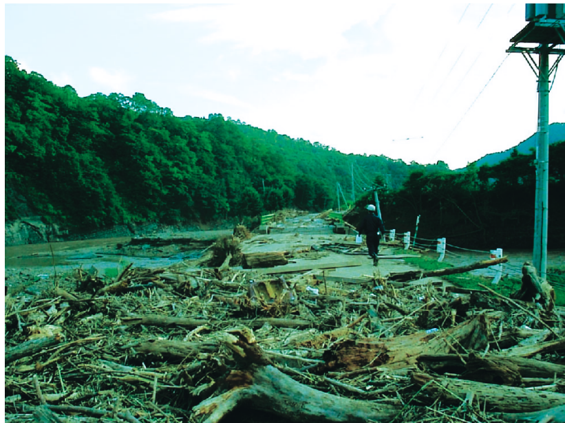
写真 1 厚別川の比宇川合流点付近の道道路比宇厚賀停車場線における洪水後の流木の散乱状況. 北海道庁提供 _ 台風被害状況資料 / 台風 10 号日高支庁管内の被害写真 ( URL:www.pref.hokkaido.jp/soumu/sm-bsbou/typhoon-10/hidaka.htm)
