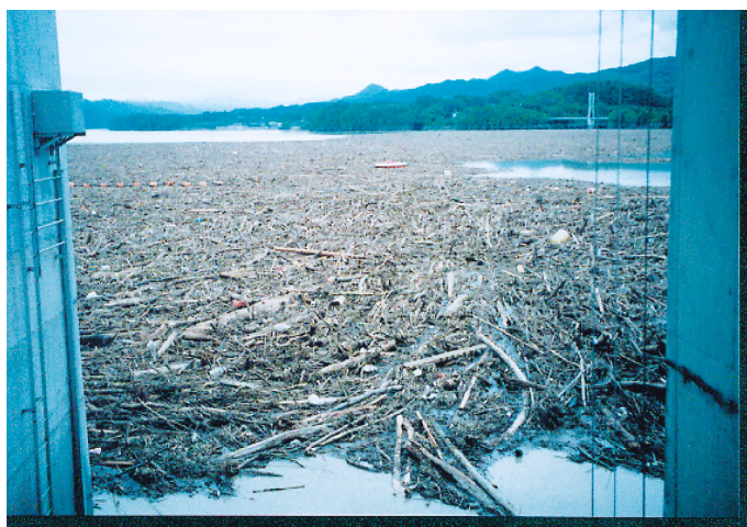
写真 3 沙流川二風谷ダムの流木流入状況 (撮影 石田武氏) Photo. 3 Driftwood at the Nibutani Dam on the Sarukawa.
