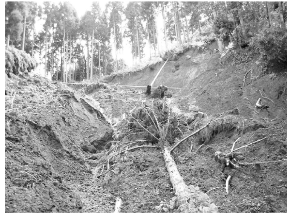
写真3 今立町相木で発生した斜面崩壊 (表4の地点2)
