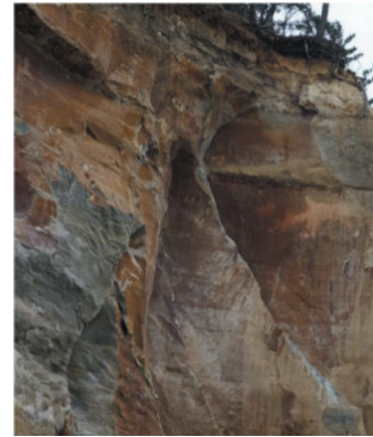
口絵 11 松川浦大橋東側(クローズアップ) Fig. 11 Close up of Fig. 10.
