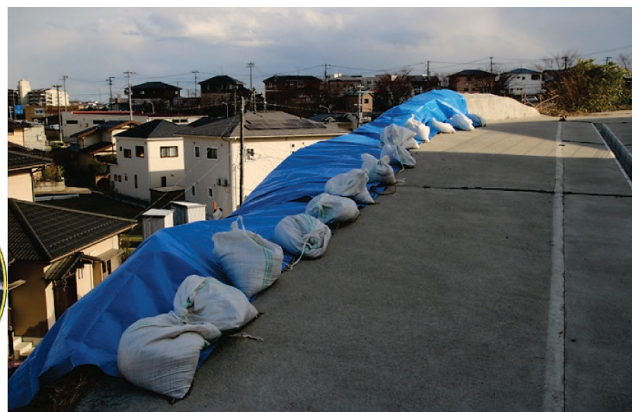
口絵 19 法面上部：コンクリートでの補強あり Fig. 19 Upper slope: There is concrete reinforcement.
