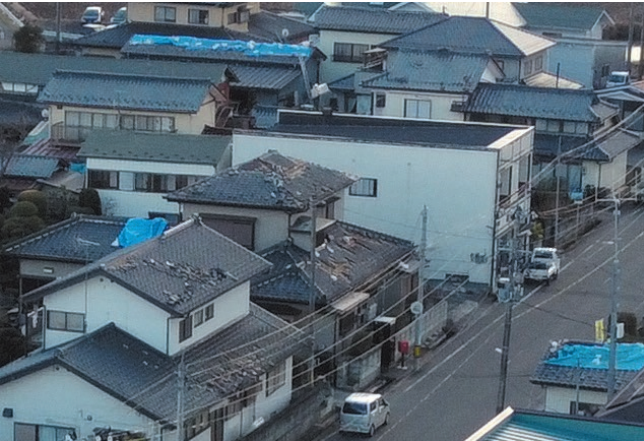
口絵 6 山元町 JR 常磐線坂元駅西側地区の建物被害 (2021.2.17 撮影)
