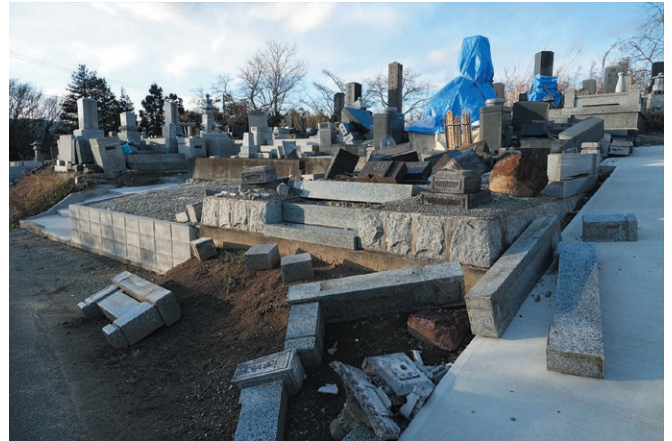
口絵 7 山元町 JR 常磐線坂元駅西側周辺の墓石の倒壊 (被害大) (2021.2.17 撮影)
