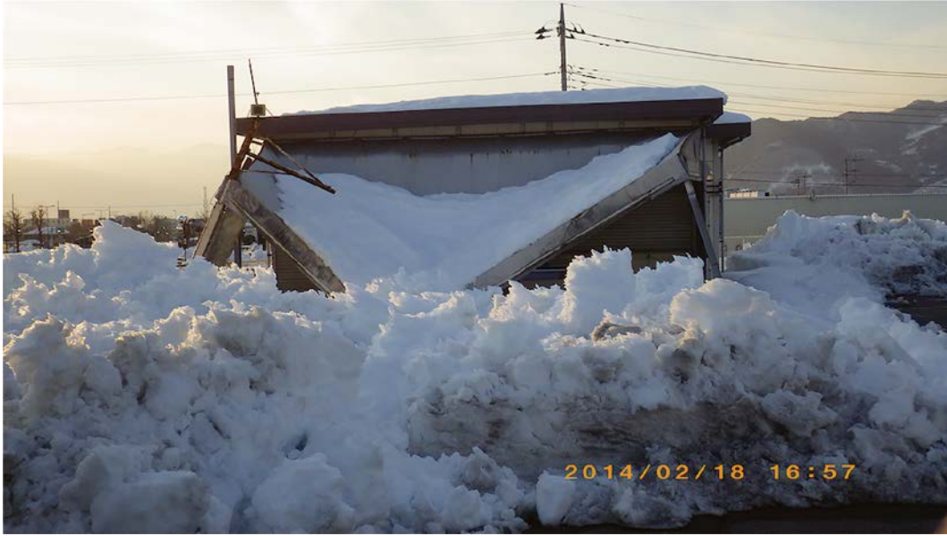
口絵 15 雪の重みで倒壊した小屋（山梨県笛吹市，2014年2月18日撮影）
