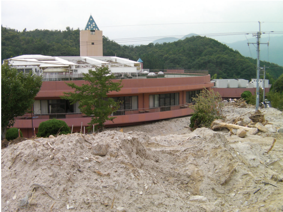
口絵 1 1階が土石流で埋まった山口県防府市真尾の特別養護老人ホーム「ライフケア高砂」 Fig. 1 Debris flow attacked the Life Care Takasago nursing home in Hofu city.
