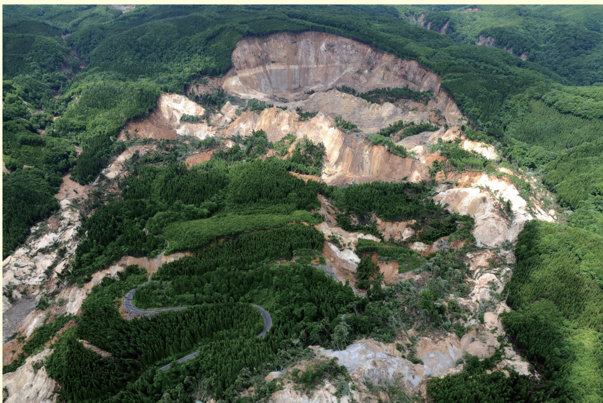
戦後最大規模で二迫川上流において発生した荒砥沢地すべりの空撮画像。道路や森林をそのままのせて300m滑った地すべりは、過去の地震で一度地すべりを起こした場所で発生した。
