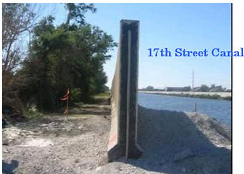
写真3 17th Street Canalの堤防断面 (M.Rohbok氏提供)
