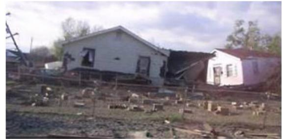
写真10 ブロックでかさ上げされただけの住宅
