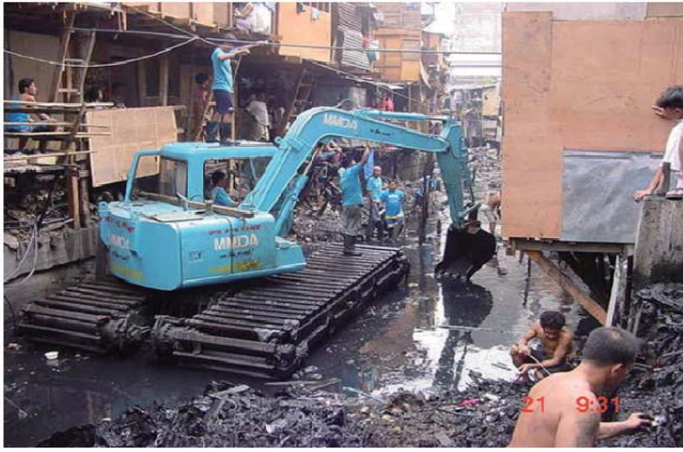
写真 12(左), 写真 13(右) マニラ首都圏の都市排水路の浚渫状況(MMDA 提供) Photo 12 & 13 Dredging urban drainage channels in Metro Manila (Courtesy of the MMDA, 2009).
