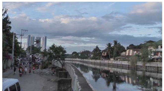
写真5 サンファン川沿いのコンクリート堤防 Photo 5 Floodwall along San Juan River.
