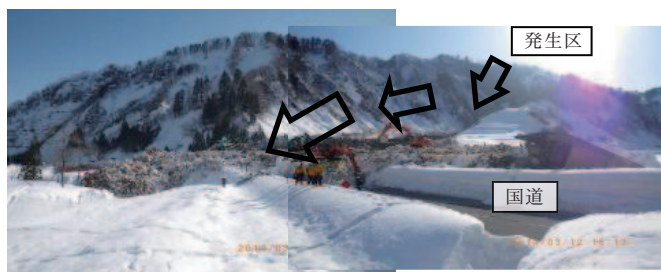
図4 地震による斜面崩壊と雪崩(新潟県十日町市) 流動性が高く流下距離が長い Fig. 4 Seismicity-induced surface snow avalanche and collapse of slope. High fluidity and long flow distance.
