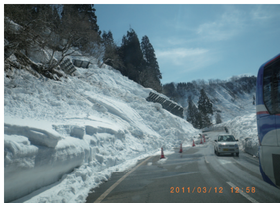
図6 雪崩予防柵を乗り越えて道路埋雪(新潟県十日町市) Fig. 6 Avalanches at slope with avalanche supporting structures.
