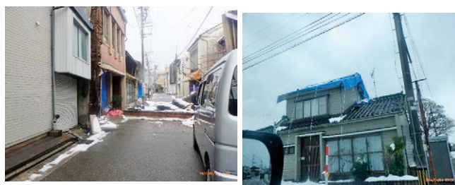
写真1 道路上への建物の倒壊と屋根上に設置されたブルーシートの状況（石川県七尾市）
