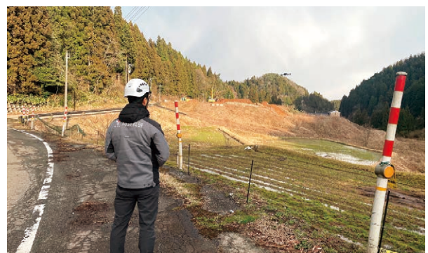
写真2 ドローンによる被害状況調査
