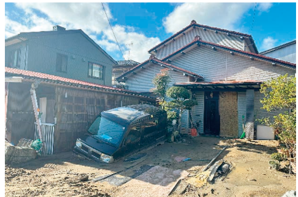
写真1 液状化被害状況（内灘町鶴ヶ崎地内、1月6日撮影）
