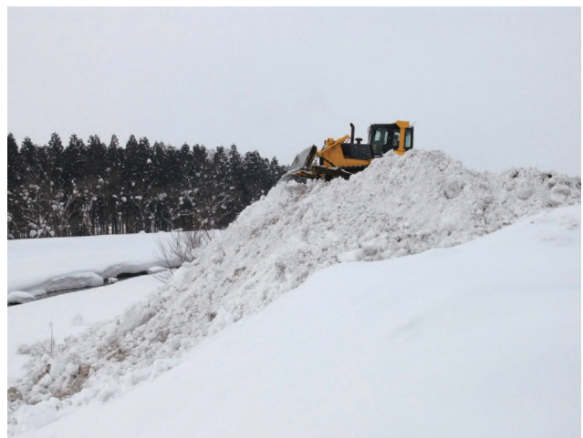
図3 ブルドーザーによる填圧作業 Fig. 3 Compression and arrangement of the snow disposal filed by a bulldozer.
