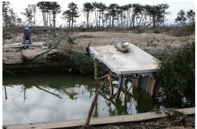
写真4 KiK-net 仙台(MYGH01)の津波による被害 Photo 4 KiK-net Sendai (MYGH01) station damaged by tsunami.
