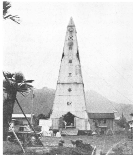
写真-1 ボーリングの全景
