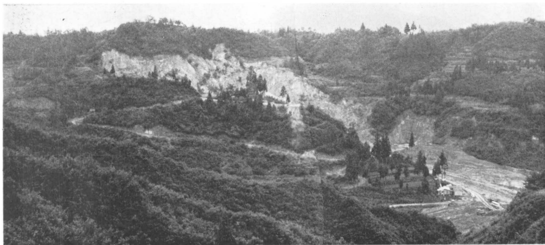
写真-1 水沢新田の地すべり性崩壊
