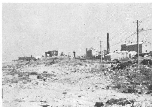
写真-5 昭和44年現在の砲台場跡
