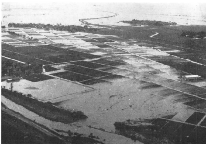
写真—2 島根県宍道湖畔河川 (S 39年7月19日破堤)
