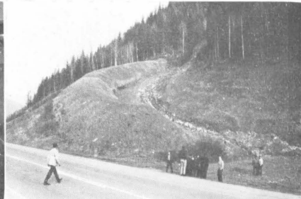
↑写真-8 ロッキー山脈中にある雪崩防止堤 の一つ、透導型土堤
