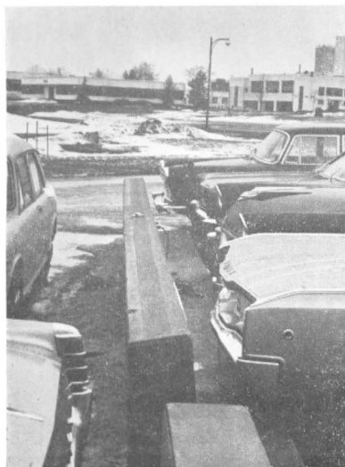
←写真-6 国立科学研究所構内での駐車場 仕切り塀の凍上による傾き
