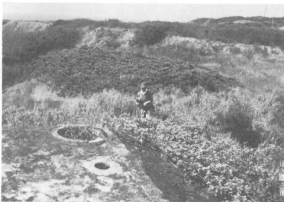
写真2 トーチカの上に降った雨を内部に導いて利用していた様子がうかがえる。このようなトーチカが多くみられる。屋根の周囲が少し高くなっているのがみえる。
