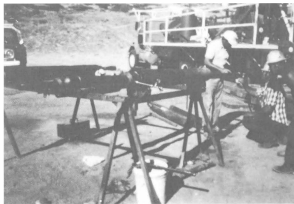
写真3 膨張バッカーの水もれ点検作業（於LH）
