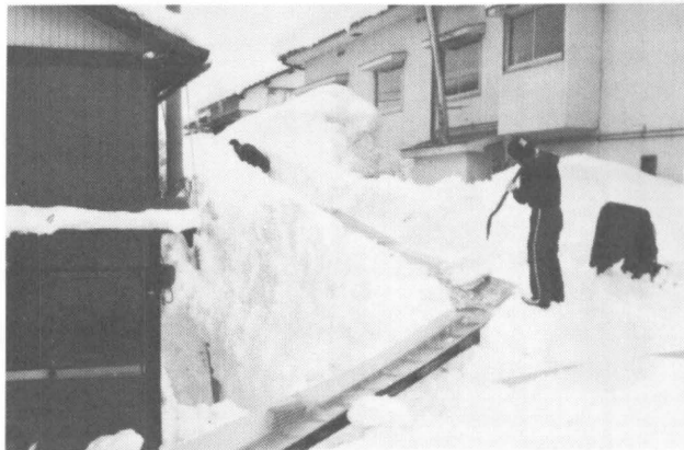
ビニール波板を利用したスノーシュートを使って 直接流雪溝へ流している（福井県大野市）
