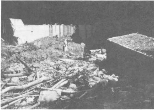
写真6 川平地区、土石流による災害
