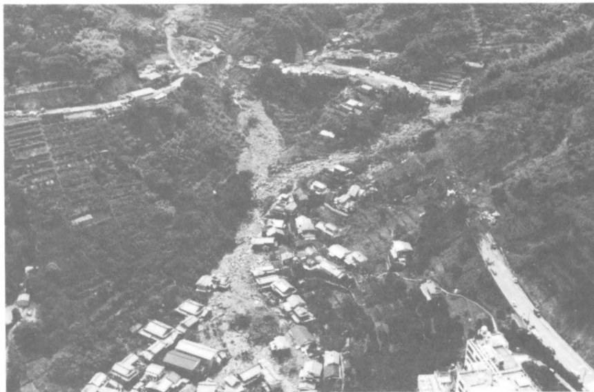
写真3 1982年7月23日長崎災害、芒塚地区、地すべり土石流による災害 （23戸全壊、9名死亡）
