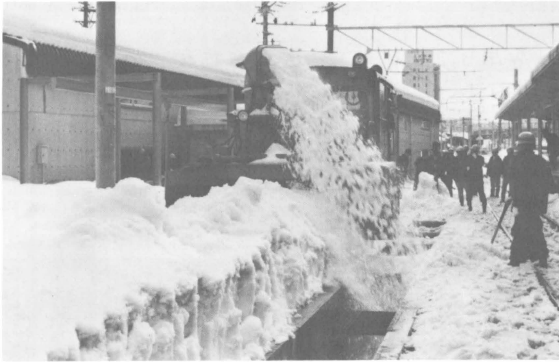
写真1 モーターカー除雪車での雪の投入
