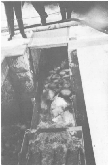
写真2 流雪溝から攪拌槽に入る状況
