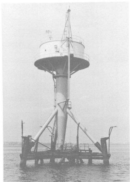
写真 1.1 波浪等観測塔
