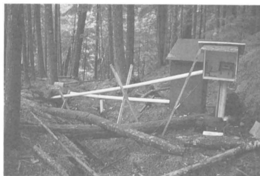
写真4. ルックアウト・クリーク地すべりへの計測機器の設置状況
