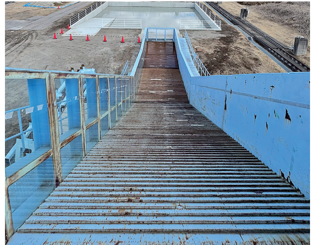
図3 大型土砂流下装置 上：流下装置全景、上部に水槽を設置し、下部に貯水槽が設置されている 下：流下装置から見下ろした下流の貯水槽
