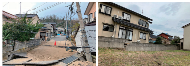
図1 能登半島地震における液状化被害事例
