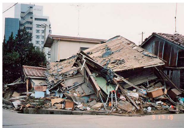
図1 兵庫県南部地震で倒壊した住宅
