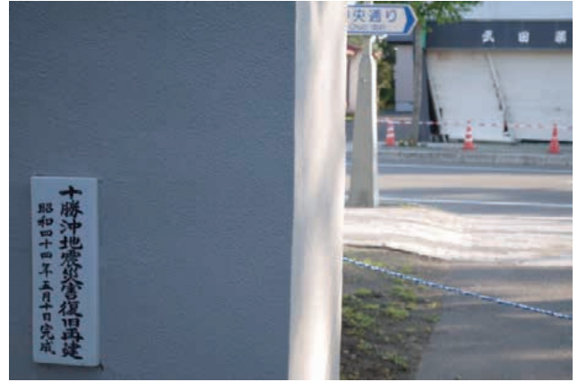
図8 むかわ町松風地区の昭和43年十勝沖地震で再建されていた寺院門柱の記録プレートと傾いた家屋(撮影日 9/15) Fig. 8 A record plate of the temple reconstructed by the 1968 Tokachi-oki earthquake in Mukawa Matsukaze district (shooting date 9/15).
