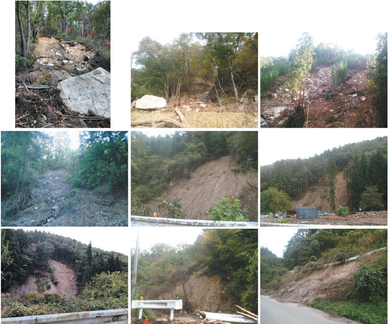
写真1 北上花崗岩類の花崗閃緑岩地域における斜面崩壊の様子。砕けたコアストーンがよく見られる。 Photo 1 Slope failures in the area of granodiorite of the Kitakami granitic rocks. Crushed corestones are usually observed.
