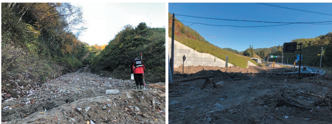
写真2 図6の地点20(普代村柏木平)の土砂流の様子。(左)流域内方向、(右)道路方向。マサ土と礫が流出し国道45号線を覆う。この地点の最大礫径は約0.5m、平均径は約0.1m。比較的小さな沢から多くの土砂が流出している。付近に同様の土砂流出が複数存在する。
