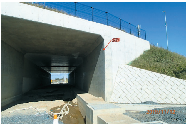
写真1 M1地点のアンダーパス Photo 1 Under path at investigation location M1.
