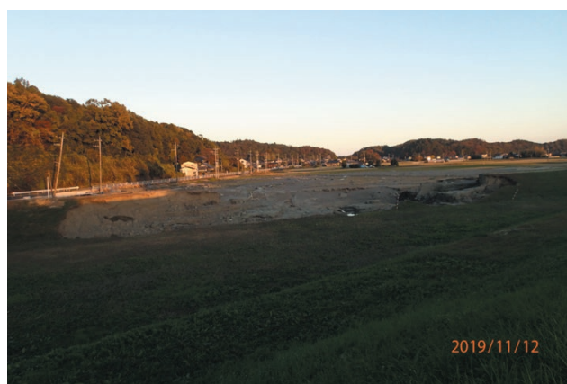
写真6 崩壊した二線堤防(図2のC2付近) Photo 6 Broken old embankment at location C2 in Fig. 2.
