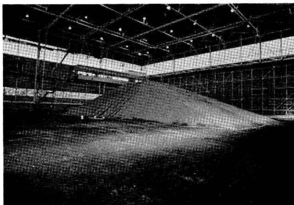
写真 3 完成した実験用斜面
