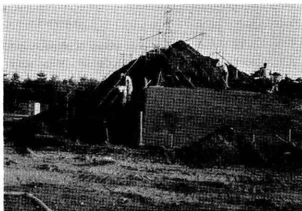
写真 2 建設中の実験用斜面
