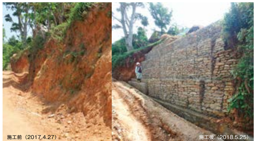
写真2 蛇籠擁壁試験施工（JICA事業）
